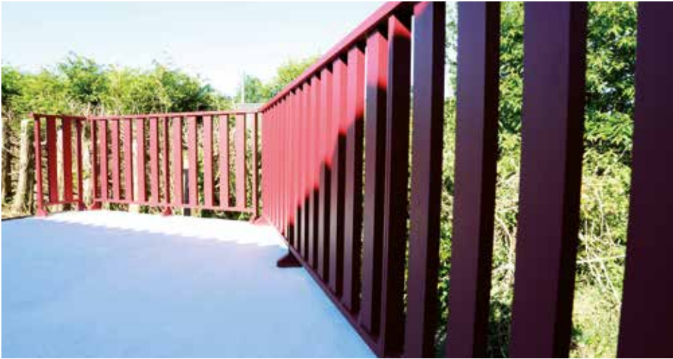
Briel Lisses verticales 15 mm obliques avec vide sous main-courante. Pose sur dalle.
